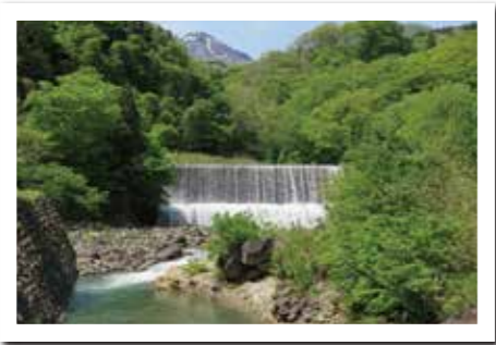
荒川第5砂防堰堤
